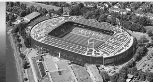
PV-Park: Werder Bremen
