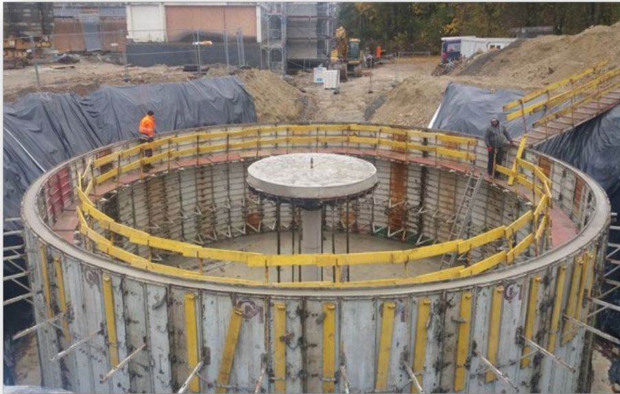
Eisspeicher Klima-Campus Lichtenau im Bau: Quelle https://www.goodmen-energy.de/projekte/lichtenau-realschule-mit-Eisspeicher-Waermepumpe
