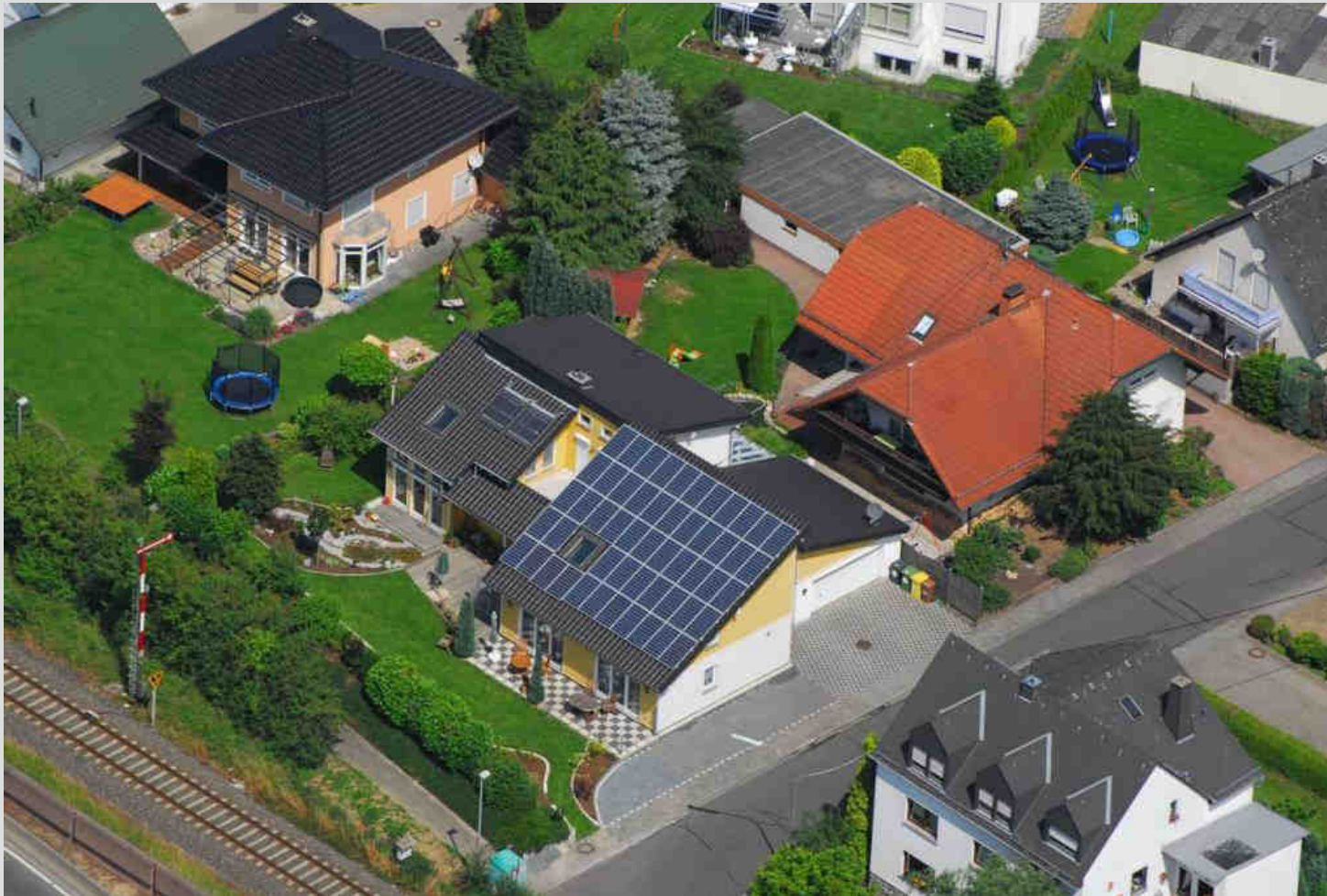
Erdwärme mit TT- Grundomat, Projekt VISSMANN
