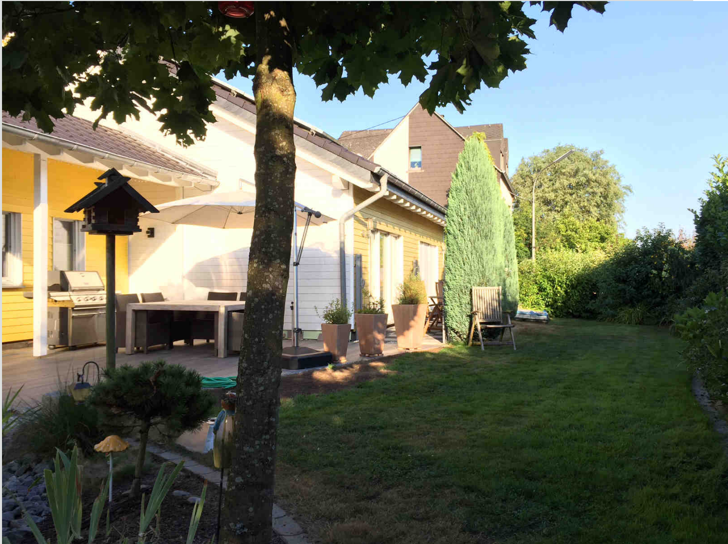
Erdwärme mit TT- Grundomat, Projekt VISSMANN
